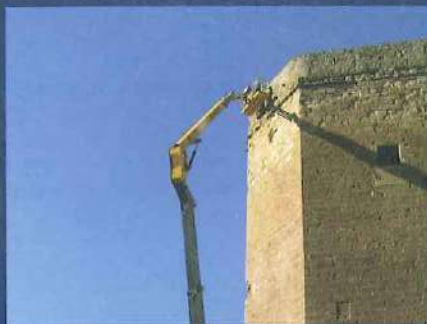
Rehabilitación paramentos Torre Norte y Noroeste
