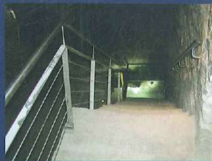
Rehabilitación Sala de Mozmorras
