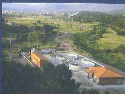
Construcción depuradora. Plan de depuración de la Comunidad Autónoma de Aragón (D.G.A.)
